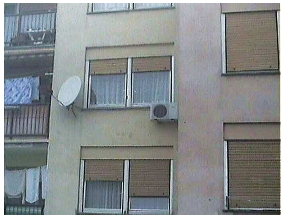
Slika 2.: Slaba toplinska izolacija vanjskog zida, prozora i kutije za rolete je uočljiva. Pri proračunu potrebno je koristiti korigirane, odnosno povećane koeficijente prolaza topline i zida i prozora od onih koji su navedeni u projektnoj dokumentaciji.
