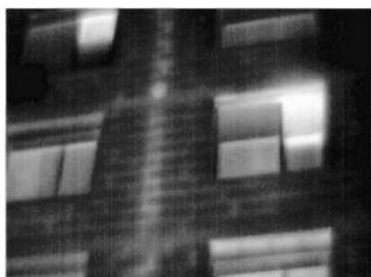
Slika 3: Toplinski mostovi na vanjskoj ovojnici zgrade [8]
